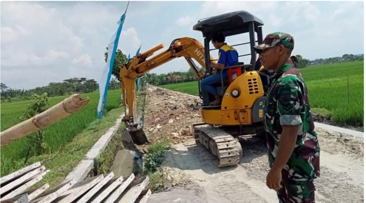
*Untuk mengoptimalkan target yang ingin dicapai di TMMD Reguler 113 Kodim 0723/Klaten mengerahkan dua alat berat berupa Excavator dan Bulldozer untuk meratakan dan mengeruk tanah yang berada di sasaran pokok jalan sepanjang 1000an meter. Selasa,(10/05/2022).*
