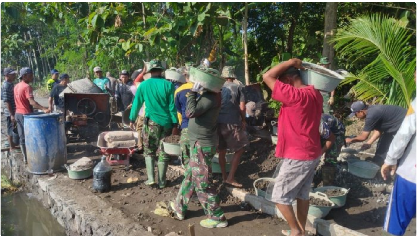
Babinsa Kodim Klaten Gotong Royong Betonisasi Jalan Program TMMD
