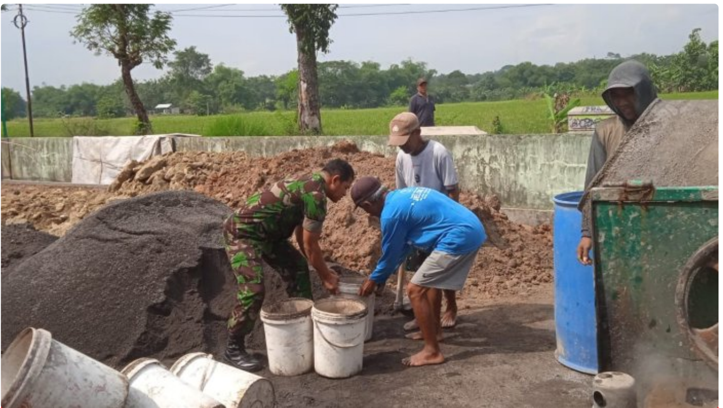
Wujud Kemanunggalan, Babinsa Wonosari Bantu Rehab Gedung Balai Desa Jelobo
